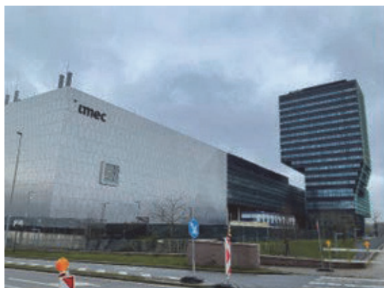
図1. Leuven 本社の imec tower と 300mmSCR
